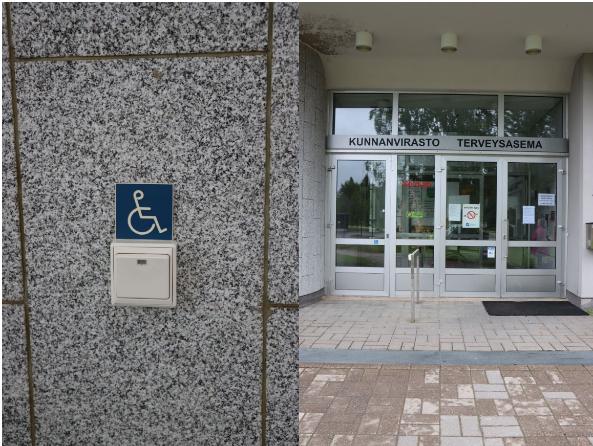
Kuva 11 ja 12. Oven avaus ja kunnanviraston sisäänkäynti, jossa vasemman puoleinen ovi sähkökäyttöinen.
