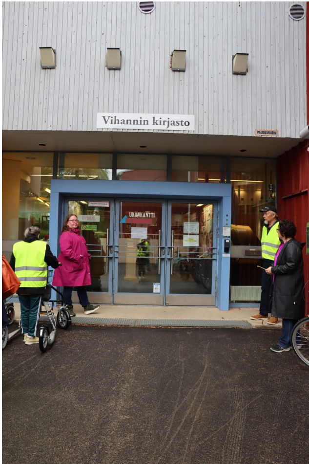
Kuva 3. Painava ulko-ovi ja korkea kynnyks.
