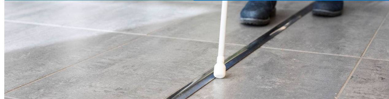
Kuva 26. Kulkemista ohjaava ohjuri sisälattiassa.
