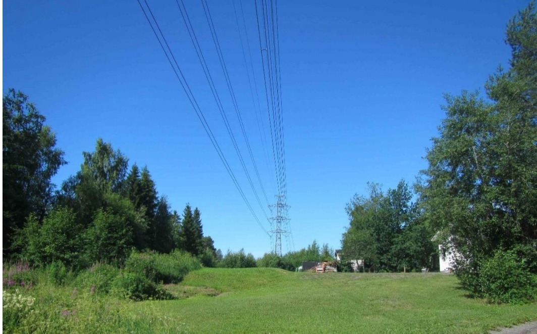
Kuva 32 Voimajohto Palonkylän asuinalueella (Fingrid Oyj, 2024)
