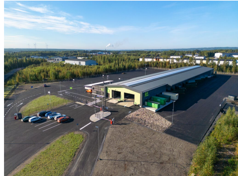
Kuva 13. Lakeuden Etapin vuonna 2024 avattu Lapuan Re-asema (Kuva: Lakeuden etappi)
