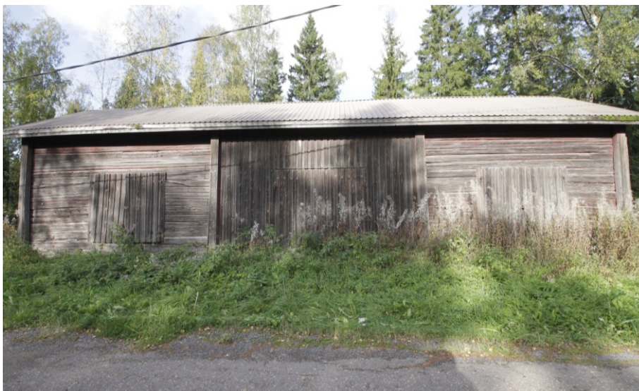
Kuva 33 Pappilan riihi kuvattuna pohjoisesta. Etualalla näkyy Kirkkoherrantietä, jonka varrella riihi sijaitsee (FCG 2025).
