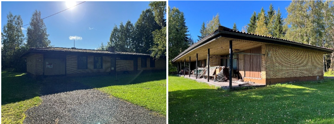
Kuva 17 Kirkkoherran asunto kuvattu etu- ja takapuolelta (FCG,2025).
