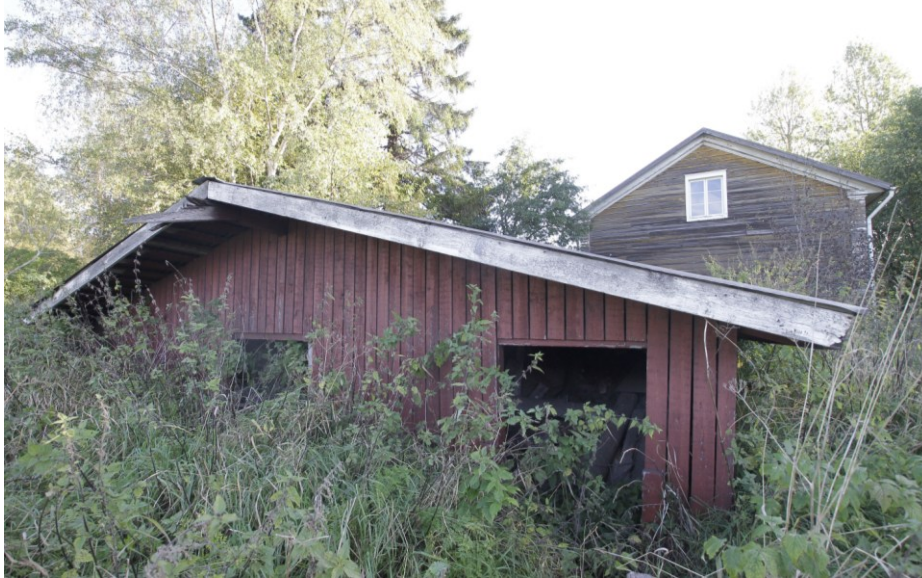
Kuva 32 Kellari kuvattuna lännestä päin. Taustalla näkyy renkitupa (FCG 2025).
