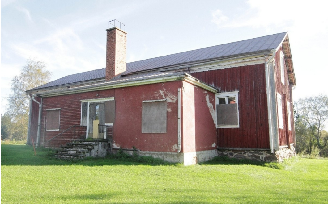
Kuva 30 Saloisten pappilan päärakennus kuvattuna lounaasta. Umpikuistin suuri tiilipiippu on rakennettu jälkikäteen (FCG 2025).
