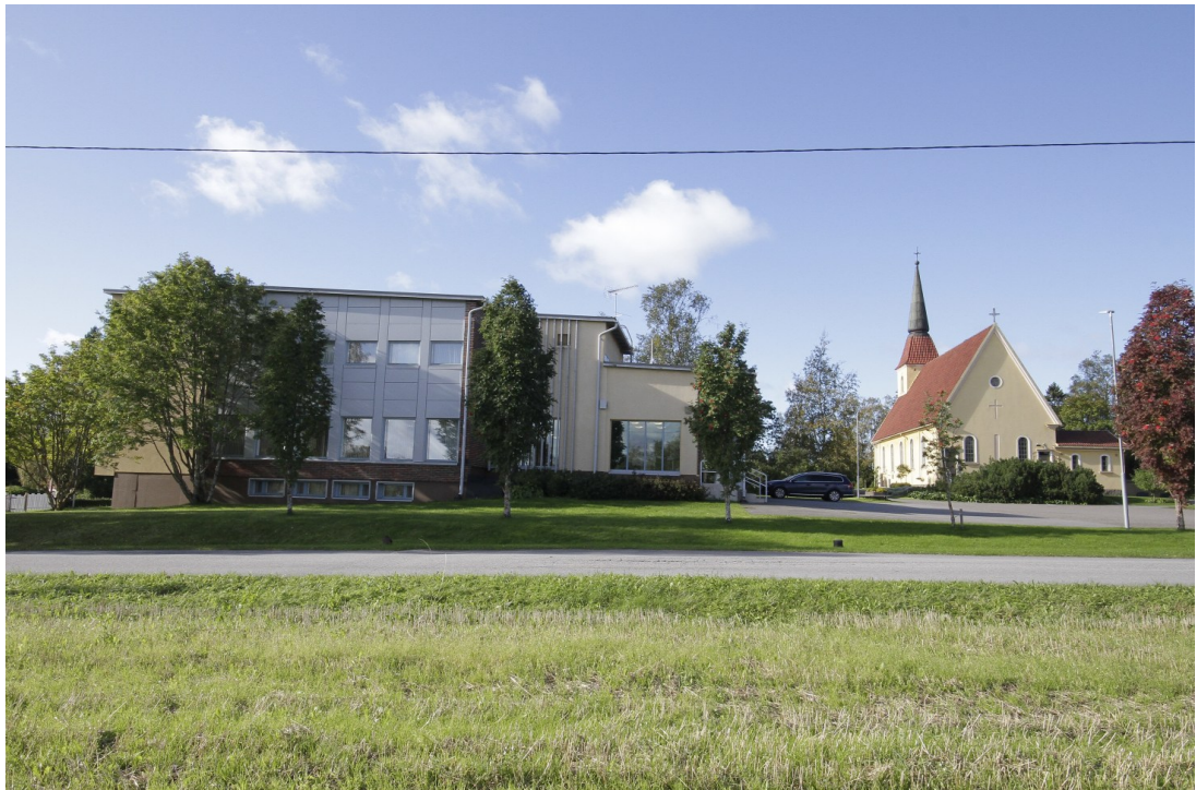
Kuva 18 Saloisten seurakuntakodin (vasemmalla) ja kirkon (oikealla) itäjulkisivut. Seurakuntakodin laajennus sijoittuu alkuperäisen rakennusosan ja kirkon väliin. (FCG, 20025)
