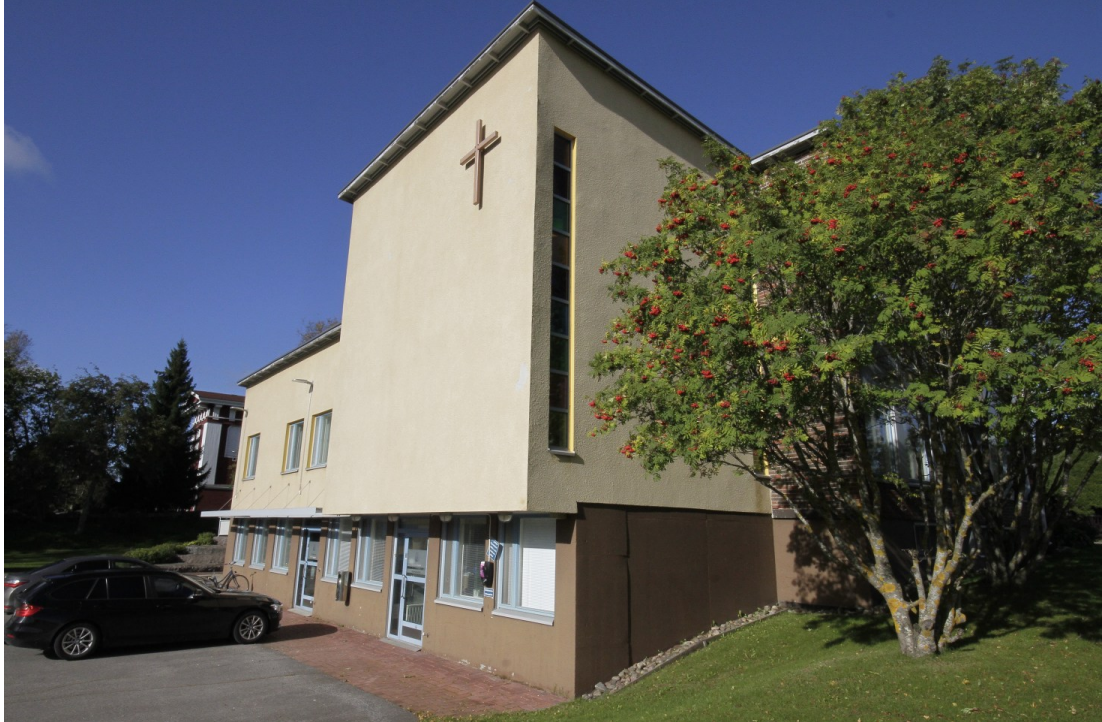
Kuva 19 Seurakuntakodin etelä- ja itäjulkisivua. Seurakuntakodin eteläosa kuuluu vuonna 1968 valmistuneeseen rakennusosaan. Lasimaalauksin koristeltujen ikkunoiden ja massoitellun perusteella on hahmotettavissa, että seurakuntasali sijoittuu muusta julkisivusta hieman ulkonevaan, korkeampaan rakennusosaan. (FCG, 20025)
