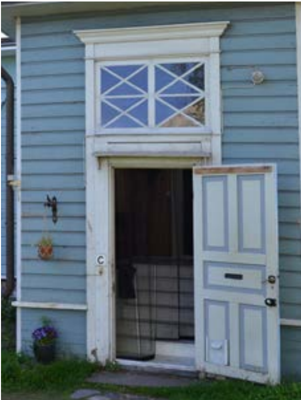
Kuva 20. Ikkunoita sisäänkäynnin yläpuolella.
