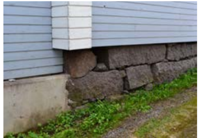
Kuva 30. Betoninen kivijalka luonnonkivisen kivijalan vieressä.
