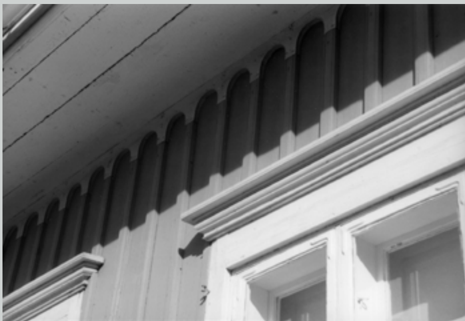
Kuva 23. Julkisivun detaljeja: Julkisivulaudoituksen liittyminen räystääsiin, ikkunoiden karmit, pitkät räystäät.
