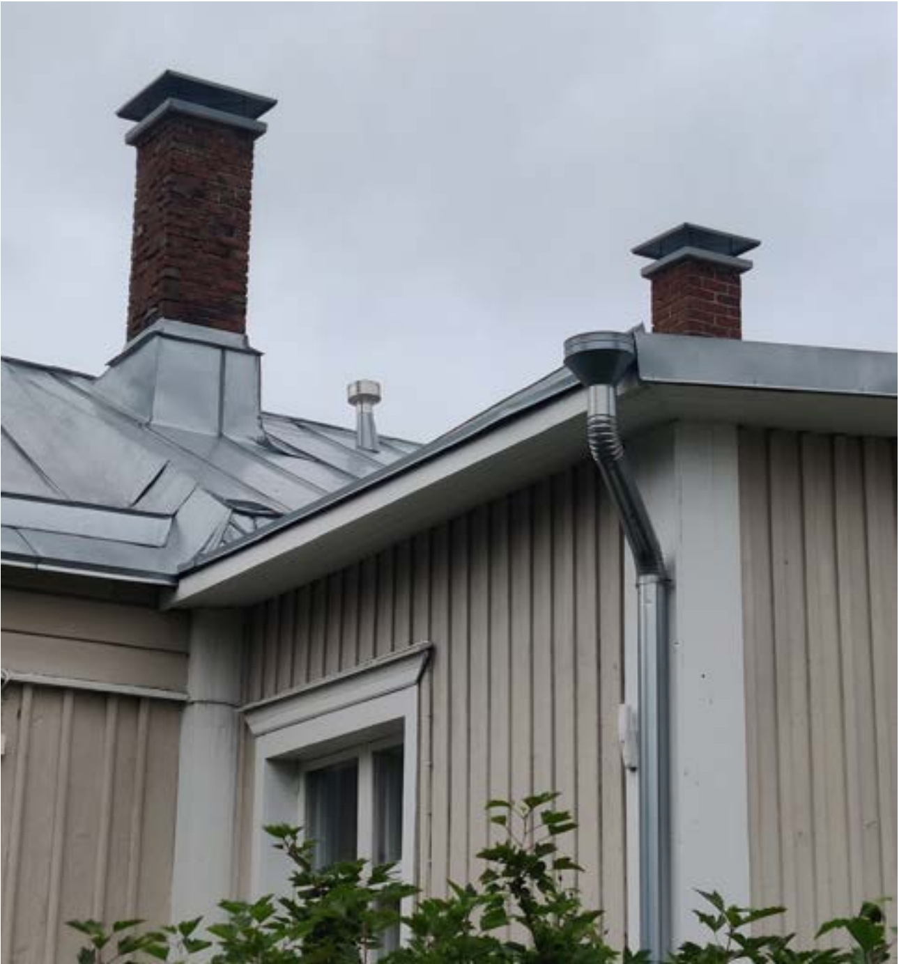
Kuva 28. Peltikatto ja tiiliset savupiiput piipunhattuineen.
