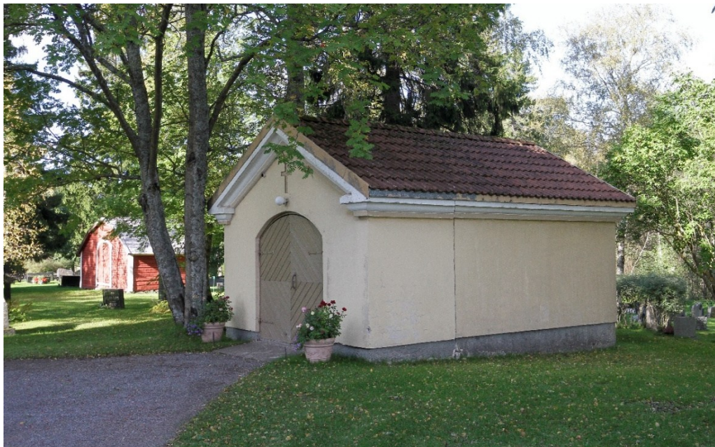
Kuva 28 Vaaleaksi rapattu ruumishuone on rakennettu 1930-luvulla samaan tyyliin kuin itse kirkkokin. (FCG 2025).
