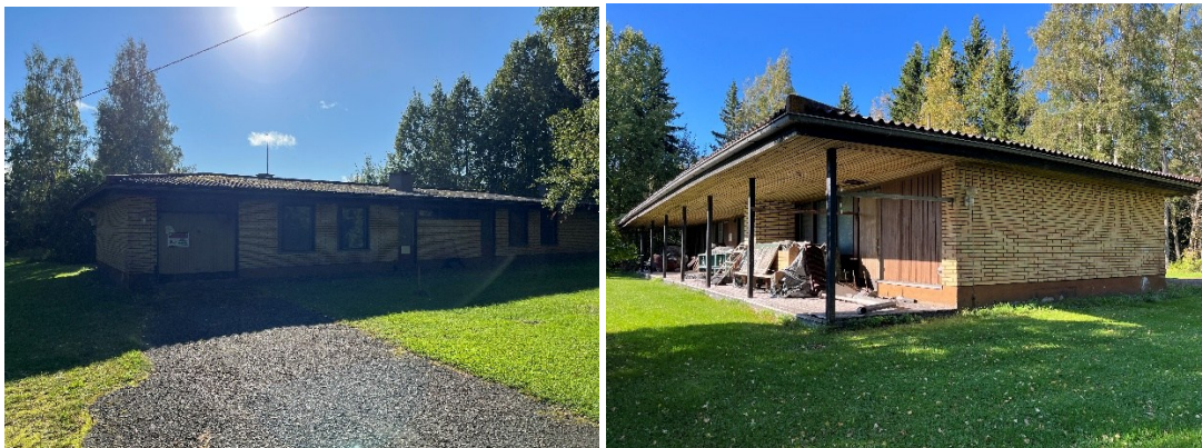
Kuva 17 Kirkkoherran asunto kuvattu etu- ja takapuolelta (FCG,2025).
