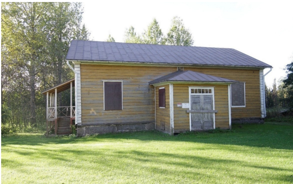
Kuva 31 Renkitupa kuvattuna pohjoisesta (FCG 2025).
