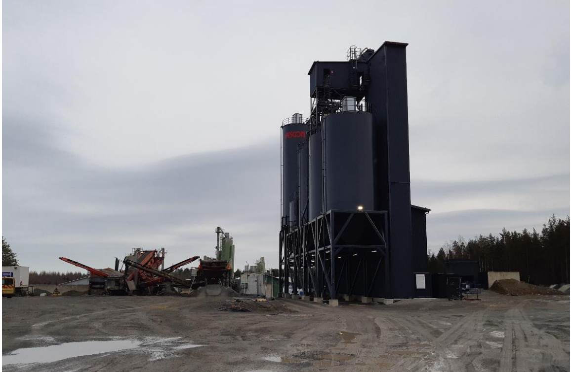
Kuva 7 Kuva uudesta tuotantolaitoksesta alueen eteläosasta pohjoiseen päin. (©Raahen kaupunki 2025)
