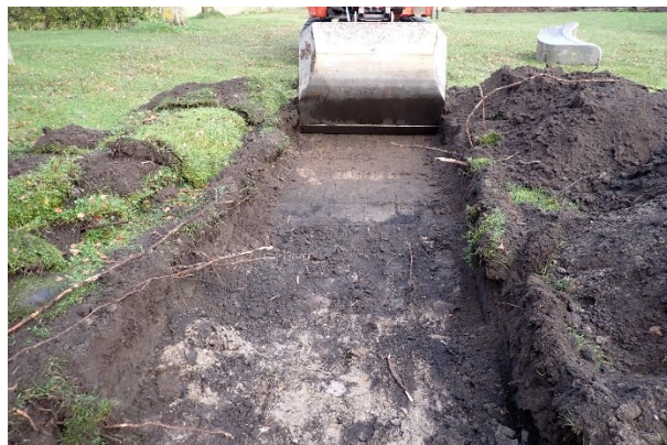
Kuva 15. Ruskean multakerroksen alla vaaleanharmaa kerros ja pohjalla nokinen maa. Etelästä.
