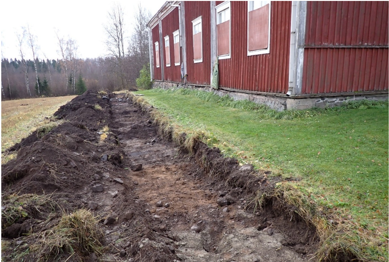
Kuva 30. Koeojan pohjoispää. Etualalla näkyy harmaata vesijohtokaivannon täyttöä. Pohjoisesta.
