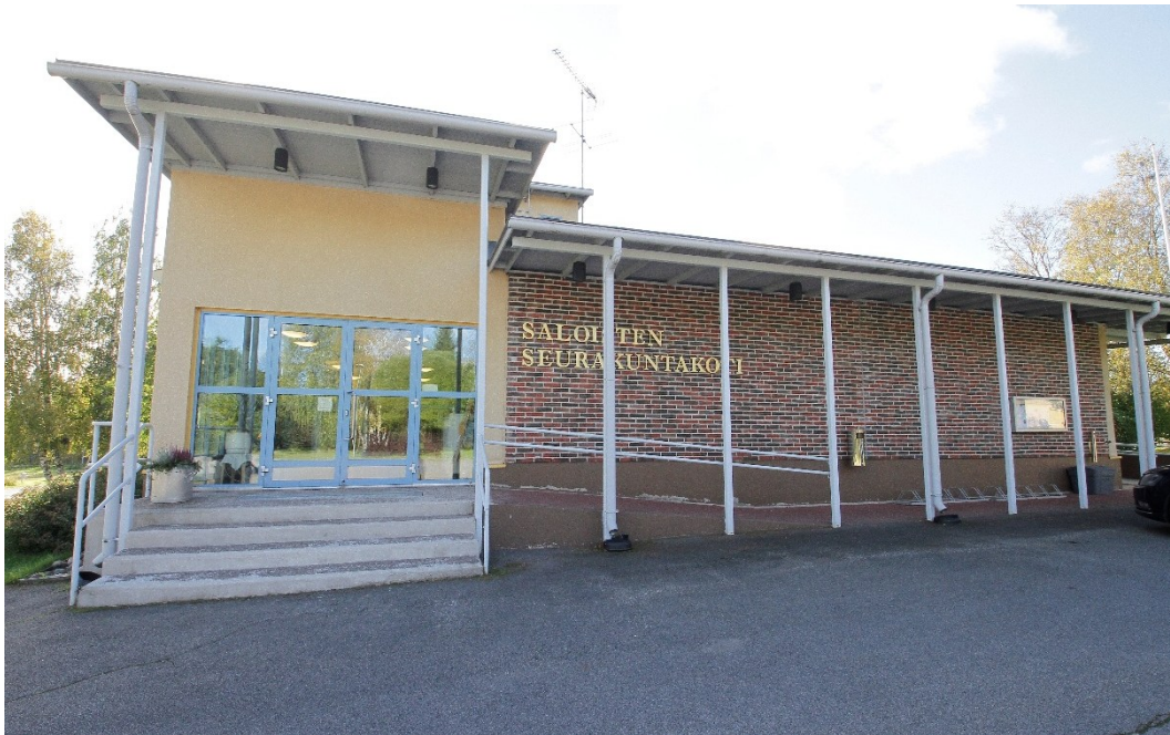
Kuva 44: Seurakuntakodin pääsisäänkäynti on pohjoisen puolella. Kuva: FCG 2025.
