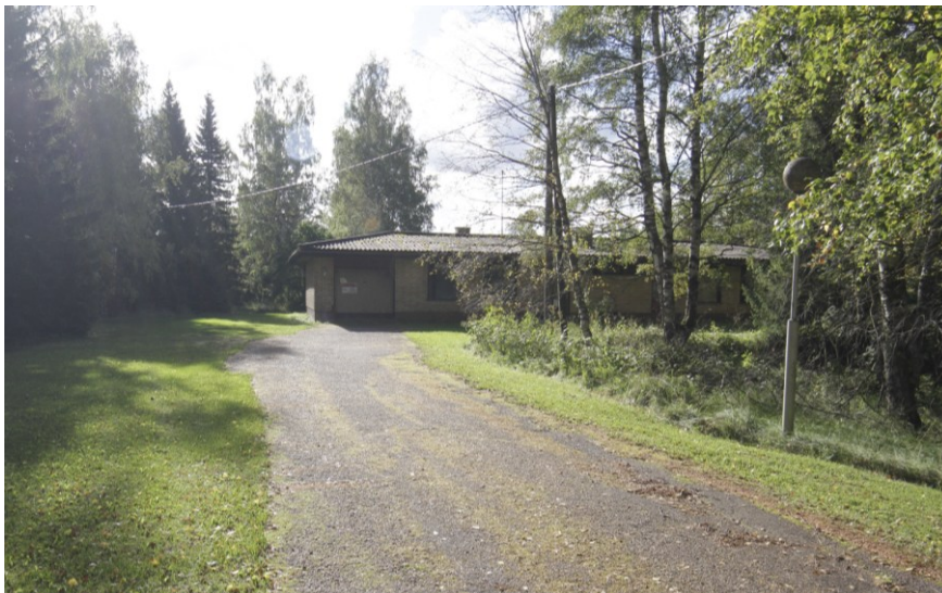
Kuva 54: Uusi pappila kuvattuna pohjoisesta Kirkkoherrantieltä. Pihatie vanhalle pappilalle jatkuu rakennuksen sivulta.
