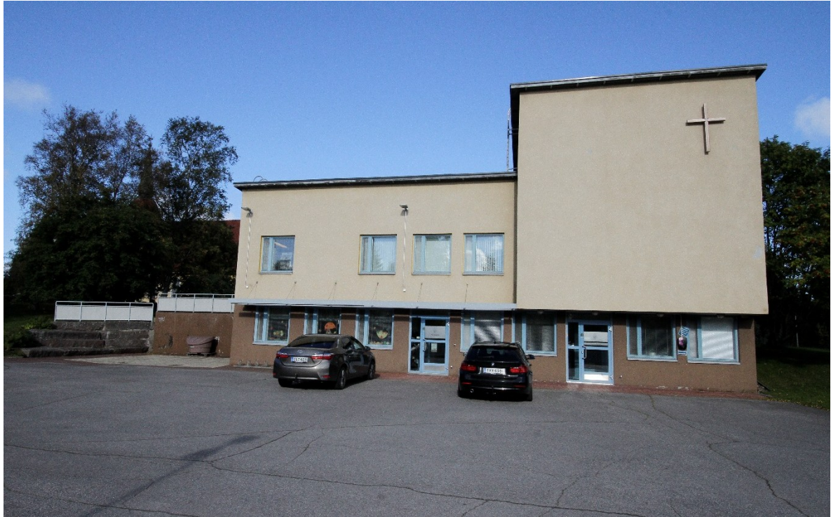
Kuva 45: Seurakuntatalon julkisivu etelän puoleisen parkkialueen puolella. Kuva: FCG 2025.
