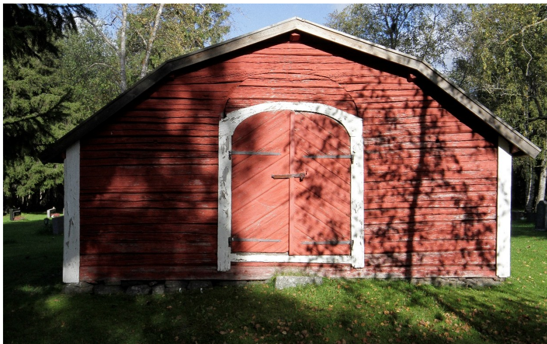
Kuva 42: Luuhuone on rakennettu viimeistään 1800-luvun loppupuolella. Kuva: FCG 2025.
