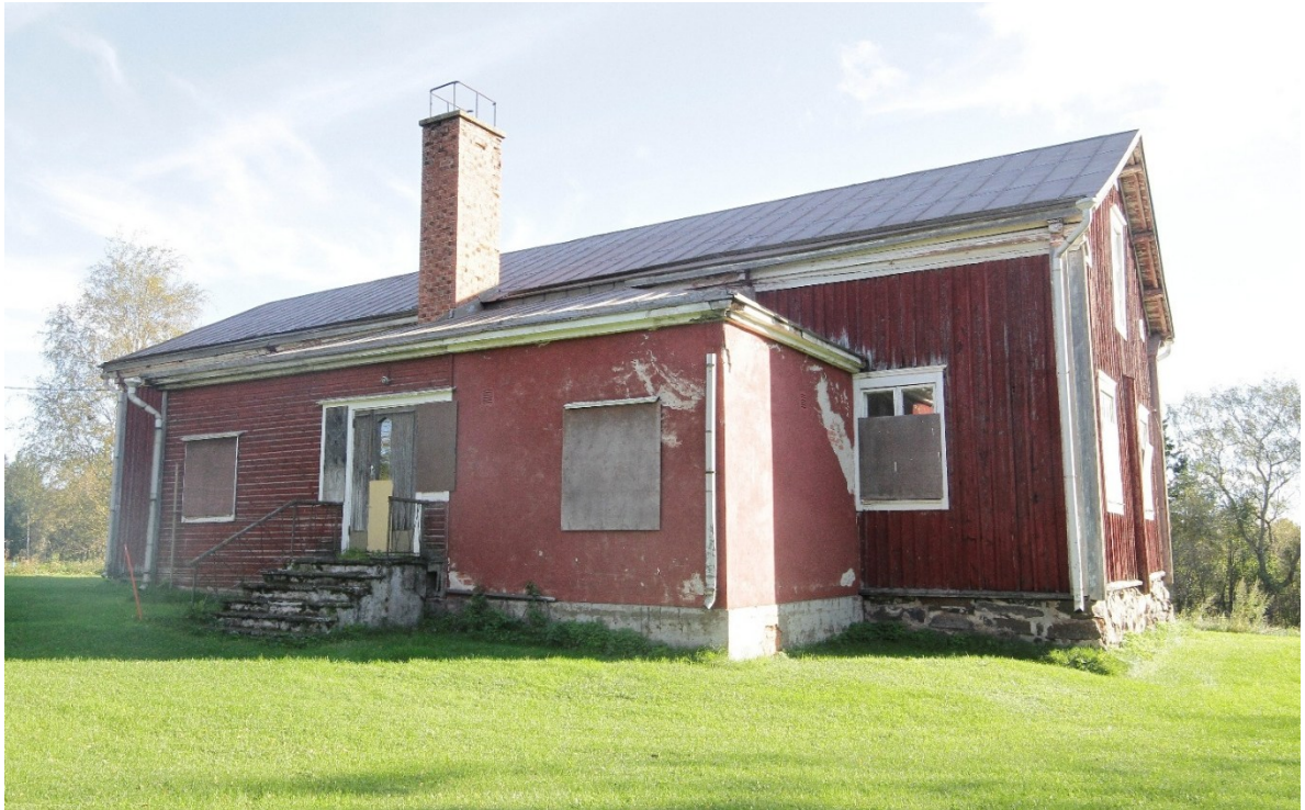
Kuva 47: Saloisten pappilan päärakennus kuvattuna lounaasta. Umpikuistin suuri tiilipiippu on rakennettu jälkikäteen. Kuva: FCG 2025.
