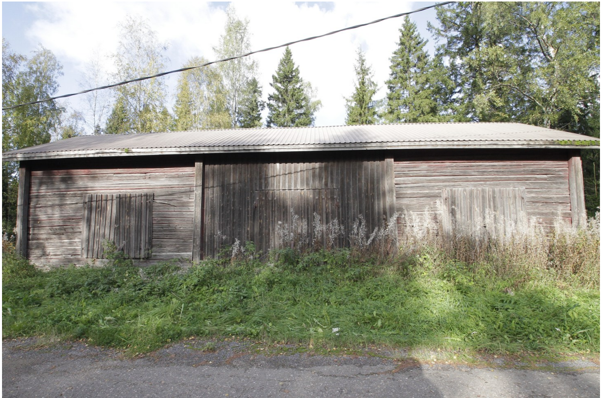
Kuva 50: Pappilan riihi kuvattuna pohjoisesta. Etualalla näkyy Kirkkoherrantietä, jonka varrella riihi sijaitsee. Kuvat: FCG 2025.
