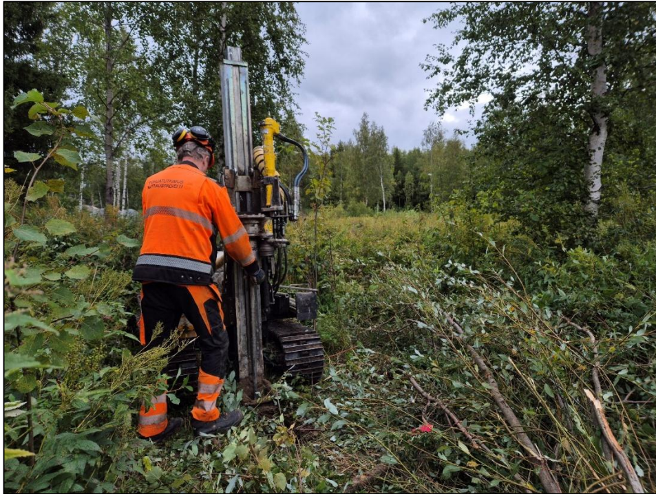
Kuva 3. Piste P019 kairaus. Pisteessä ei todettu otettujen näytteiden perusteella potentiaalisesti happamia sulfaattimaita.
