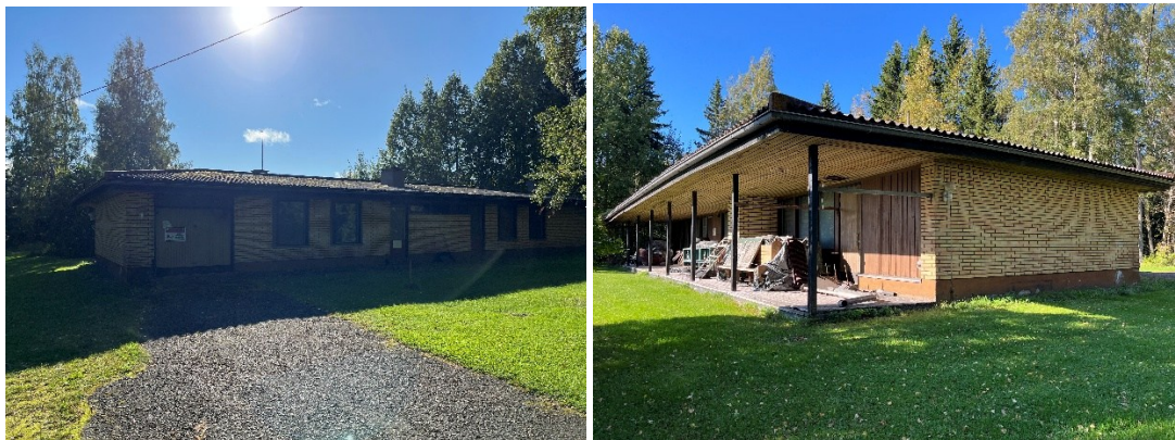
Kuva 17 Kirkkoherran asunto kuvattu etu- ja takapuolelta (FCG,2025).
