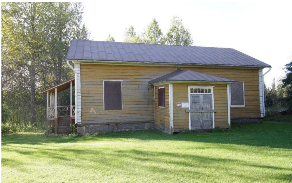
Kuva 31 Renkitupa kuvattuna pohjoisesta (FCG 2025).
