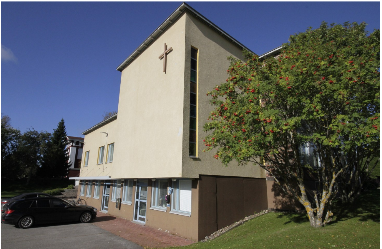
Kuva 5 Seurakuntakodin etelä- ja itäjulkisivua. Seurakuntakodin eteläosa kuuluu vuonna 1968 valmistuneeseen rakennusosaan. Lasimaalauksin koristeltujen ikkunoiden ja massoitellun perusteella on hahmotettavissa, että seurakuntasali sijoittuu muusta julkisivusta hieman ulkonevaan, korkeampaan rakennusosaan.
