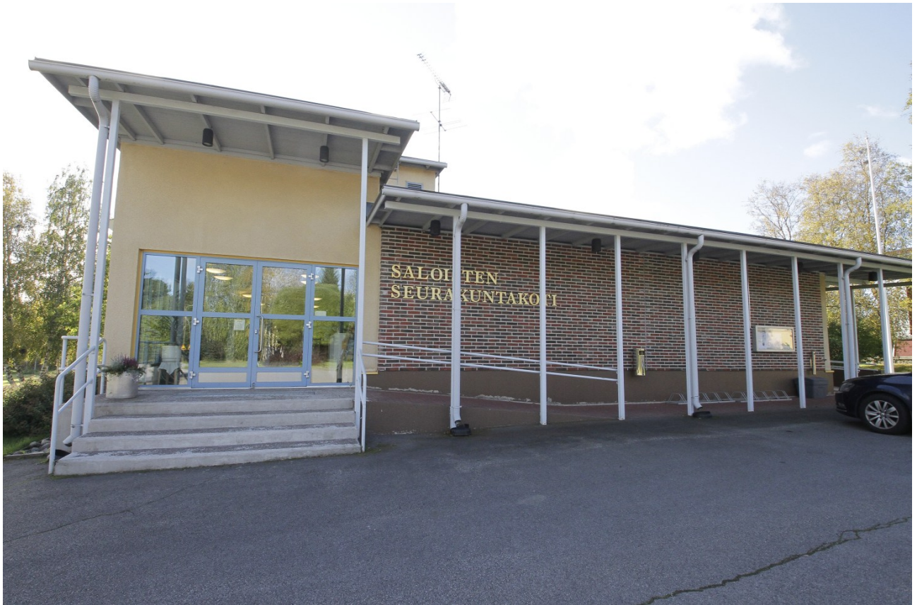
Kuva 4 Saloisten seurakuntakodin pohjoisjulkisivulla on pääsisäänkäynti. Seurakuntakotia laajennettiin vuonna 2007 pohjoiseen ja kuvassa näkyvät rakennusosat ovat laajennusosaa.
