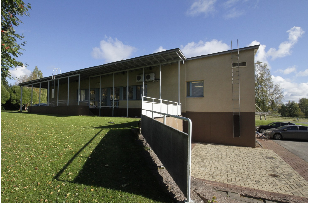
Kuva 8 Seurakuntakodin länsijulkisivu. Länsijulkisivua hallitsee laajennuksen aikainen katos.
