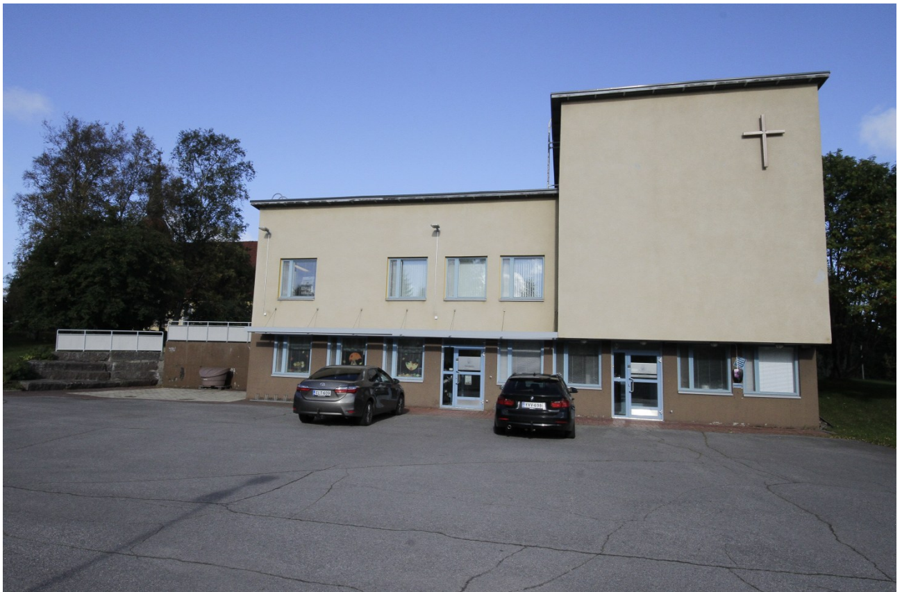
Kuva 7 Seurakuntakodin eteläjulkisivu. Kuvan oikeassa reunassa näkyy muusta julkisivusta ulkoneva seurakuntasali.
