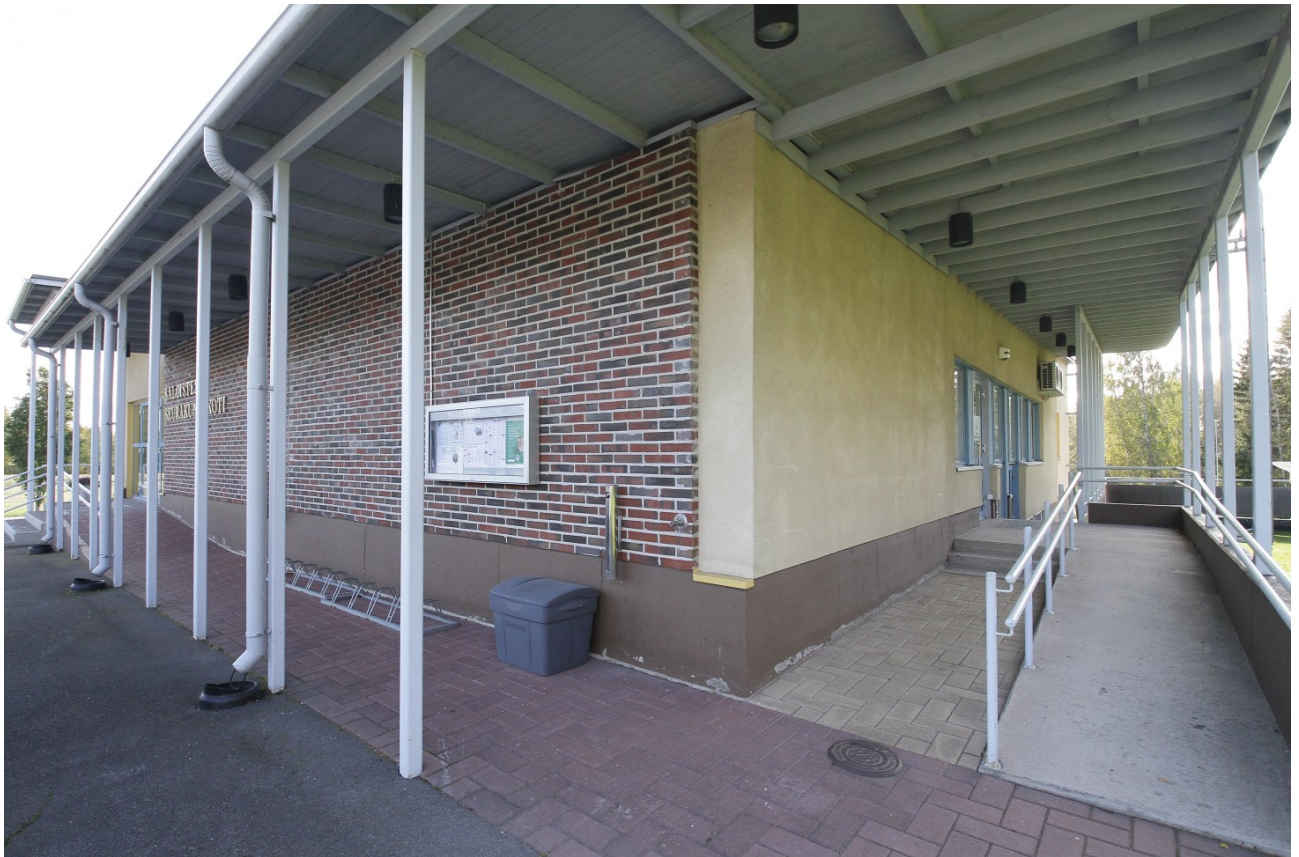
Kuva 10 Seurakuntakodin luoteiskulma. Rakennuksen pohjoisosa ja sisääntuloja kattava kattorakenne on 2000-luvun laajennuksen ajalta.
