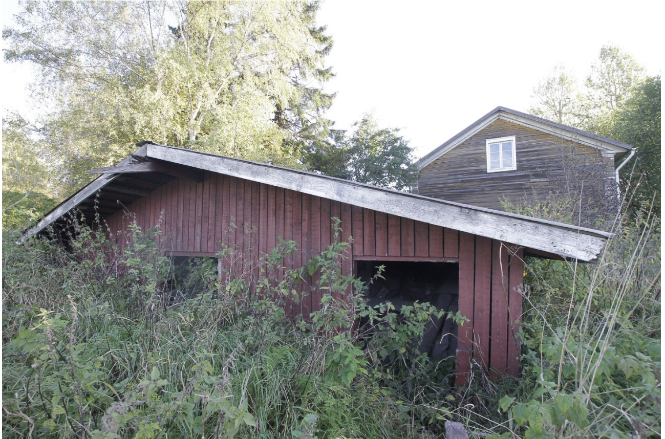
Kuva 13 Kellarin länsijulkisivu (edessä) ja renkituvan länsijulkisivu (takana).
