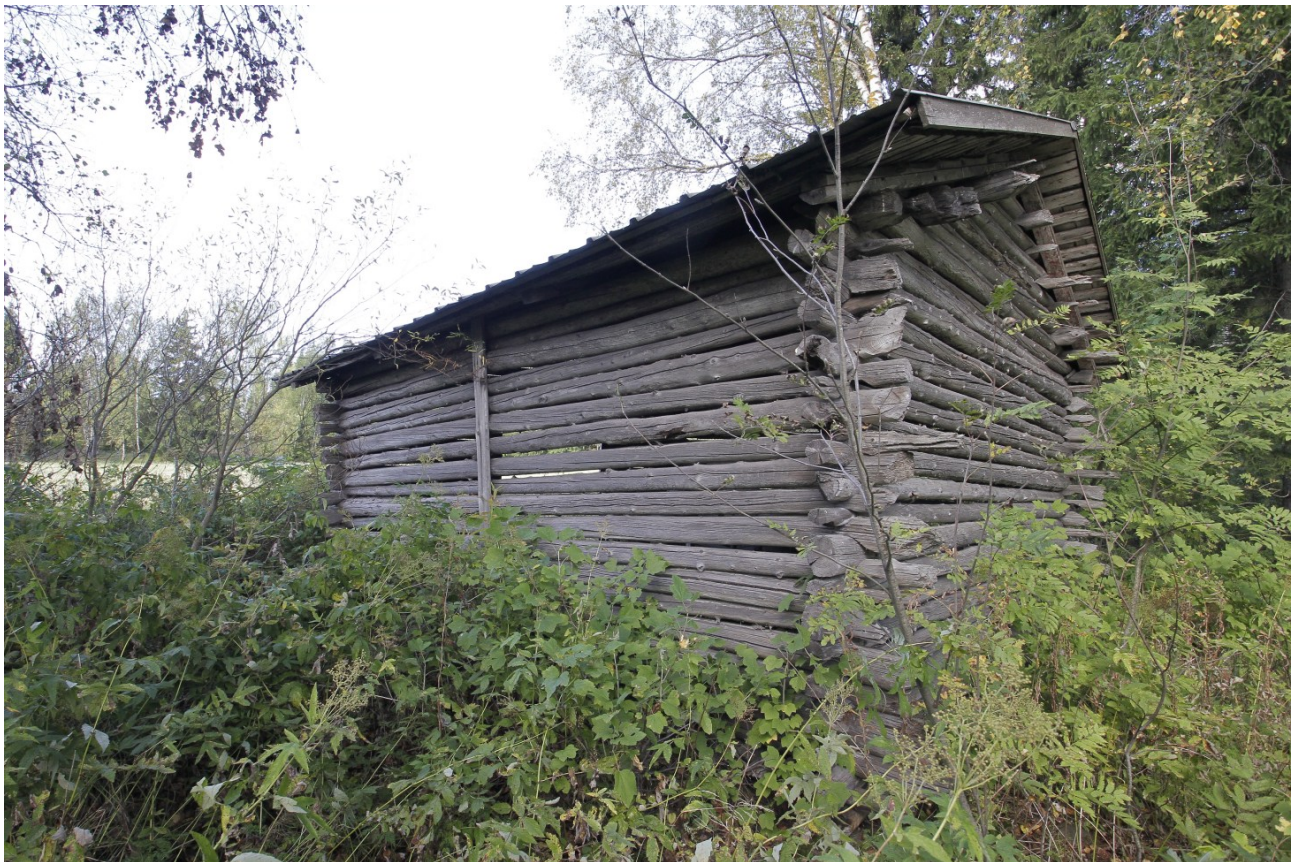
Kuva 22 Aitan 2 etelä- ja itäjulkisivut.
