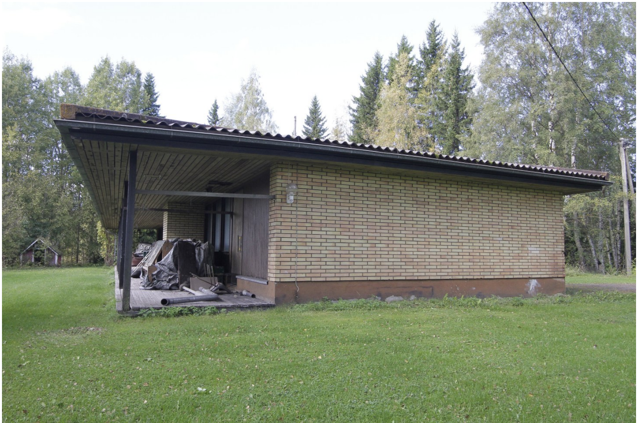
Kuva 26 Uuden pappilan itäjulkisivu.
