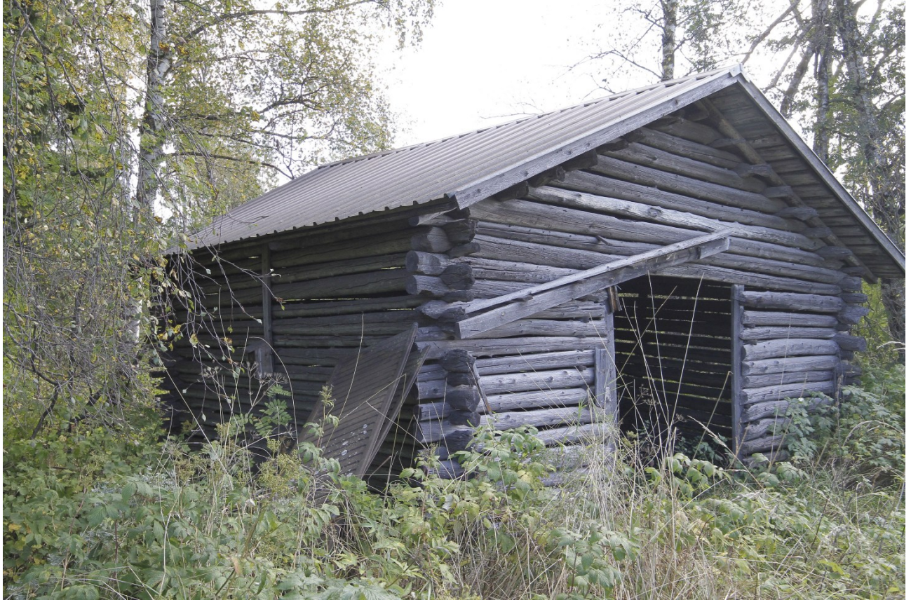
Kuva 21 Aitan 2 pohjois- ja länsijulkisivut.
