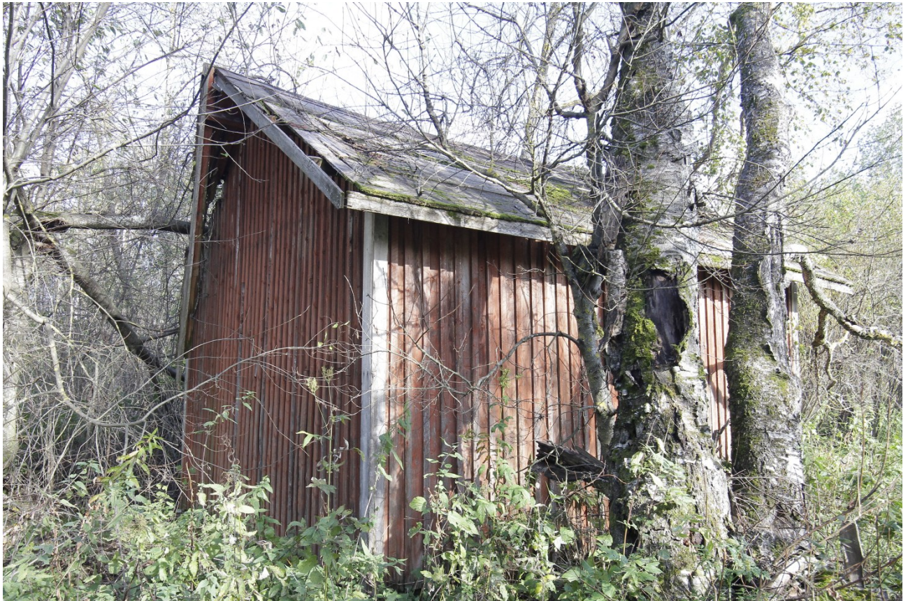
Kuva 24 Talousrakennuksen itä- ja eteläjulkisivut.
