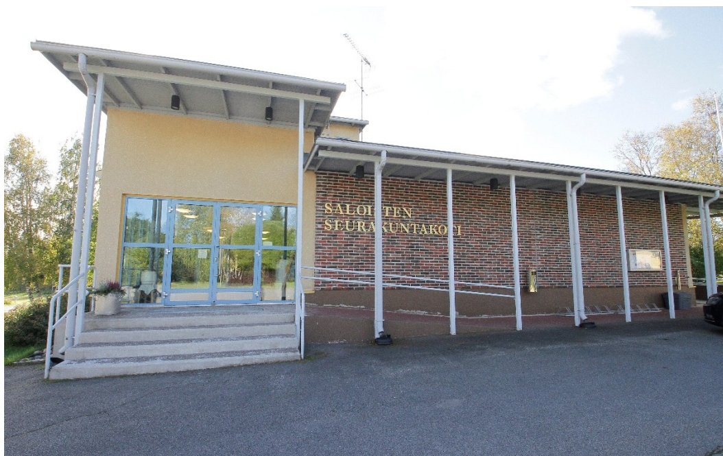
Kuva 42: Seurakuntakodin pääsisäänkäynti on pohjoisen puolella. Kuva: FCG 2025.
