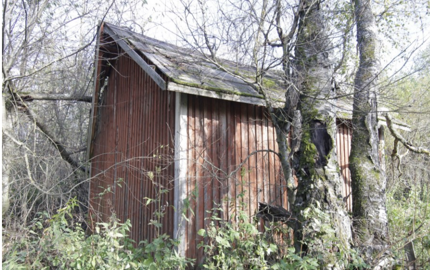
Kuva 51: Varastorakennus kuvattuna lounaasta. Kuva: FCG 2025.
