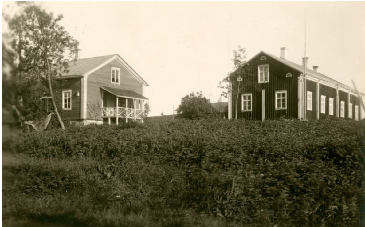
Kuva 23: Saloisten pappila kuvattuna kaakosta. Vasemmalla 1700-luvun renkitupa ja oikealla 1800-luvun pappilan päärakennus. Rakennusten välistä hahmottuu pihapiirin muiden rakennusten – mahdollisesti aitan ja pirtin – kattoja. Ajoittamaton valokuva. Kuvaaja: tuntematon. Lähde: Finna / Suomen Elinkeinoelämän Keskusarkisto. Seurakuntain keskinäinen Palovakuutusyhtiö (1812–1968). Saloisten pappila, 2561/2129.
