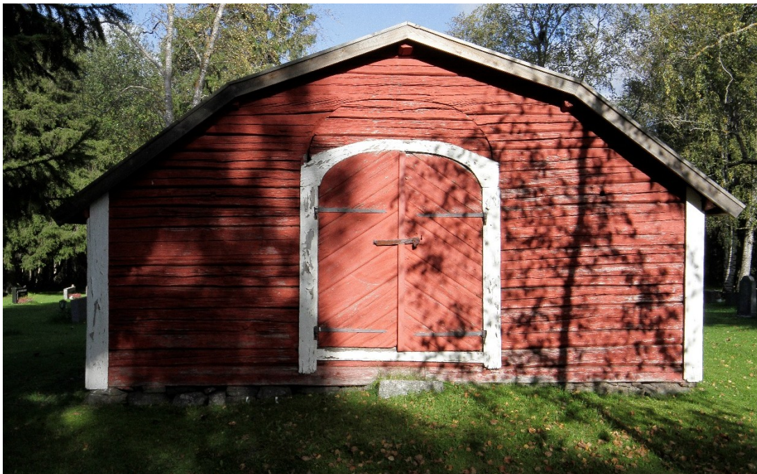
Kuva 40: Luuhuone on rakennettu viimeistään 1800-luvun loppupuolella. Kuva: FCG 2025.
