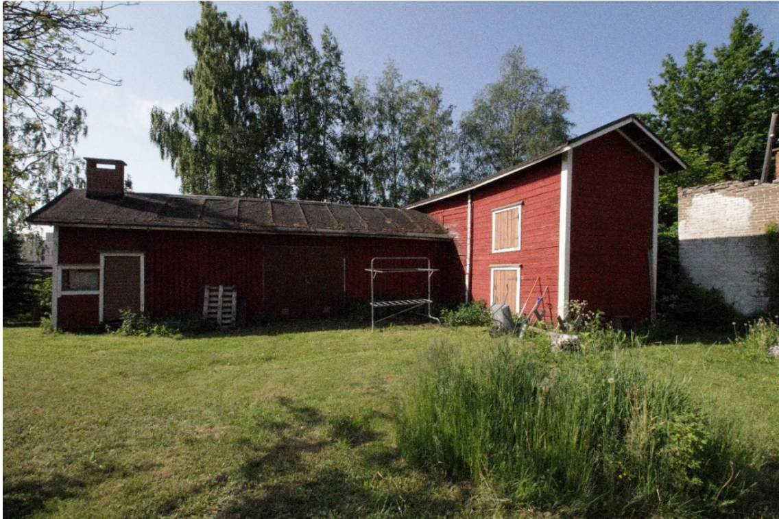
Kuva 4. Tontin perällä olevan talousrakennuksen pihan puoleinen julkisivu. Kuvan vasemmassa reunassa näkyy yksikerroksinen itä-länsisuuntainen siipi, jossa on sauna ja autotalli. Kuvan oikeassa reunassa näkyy kaksikerroksinen riviäitän, joka on pohjois-eteläsuuntainen. Sen takaa näkyy naapuritontilla olevaa sementtitiilimuurattua palokatkoa. Rakennuksen ulkonäköä on kuvailtu edellä luvussa "Rakennuksen kuvaus".
