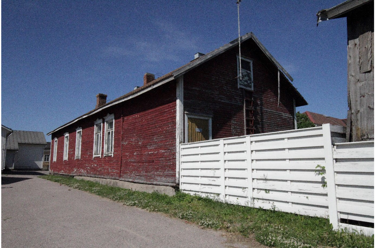
Kuva 2. Tontin eteläsivulle sijoittuu asuinrakennuksena käytetty piharakennus, jonka päädystä alkaa naapuritontillekin jatkuva korkea lauta-aita. Rakennuksen ulkonäköä on kuvailtu edellä luvussa "Rakennuksen kuvaus".
