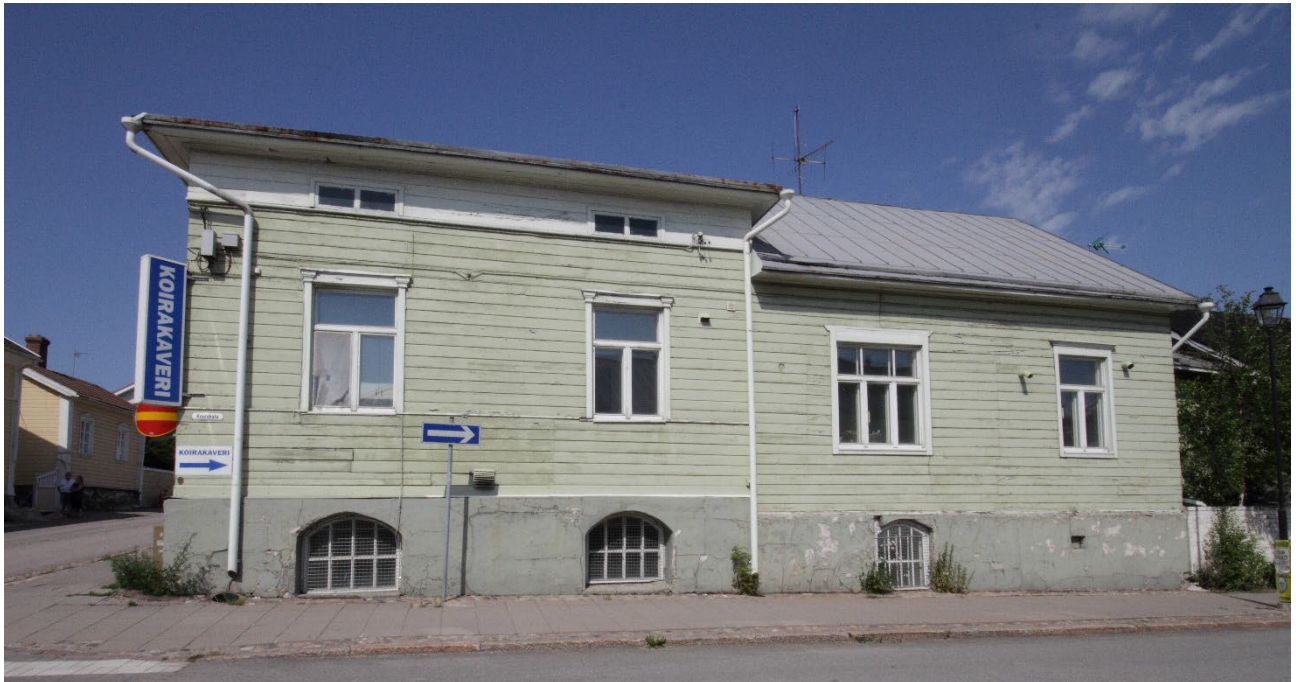
Kuva 2. Kohteen päärakennus Koulukadun ja Kauppakadun kulmassa. Kuvassa näkyy rakennuksen Koulukadun puoleinen julkisivu. Rakennuksen Kauppakadun suuntainen rakennusosa on aumakattoinen ja Koulukadun puoleinen osa harjakattoinen. Rakennuksen ulkonäköä on kuvailtu edellä luvussa "Rakennuksen kuvaus".
