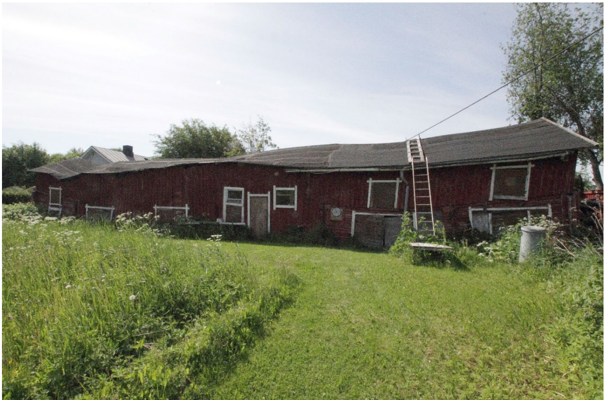
Kuva 9. Kohteen pihan perällä oleva pitkä talousrakennus. Rakennus koostuu yhteen rakennetuista aitoista ja eläinsuojista. Rakennuksen katto on pahoin notkolla eteläpäässä. Rakennuksen ulkonäköä on kuvailtu edellä luvussa "Rakennuksen kuvaus".
