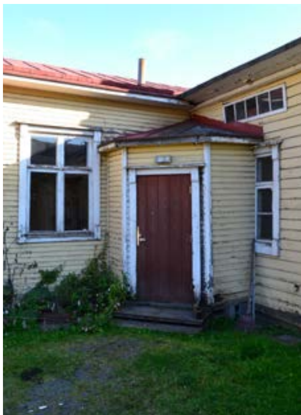
Kuva 19. Sisäänkäynti rakennuksen sisäkulmas- sa.
