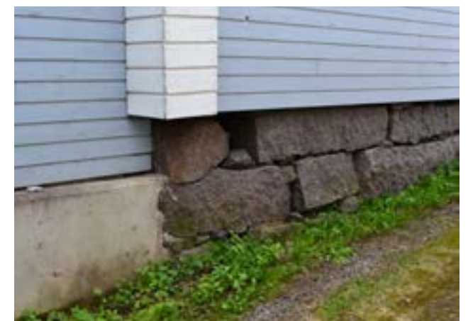
Kuva 30. Betoninen kivijalka luonnonkivisen kivijalan vieressä.
