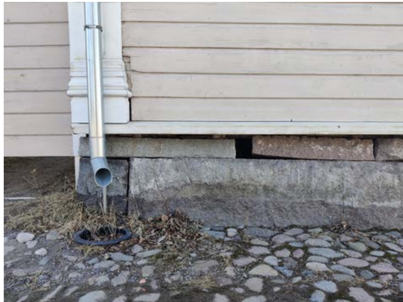
Kuva 31. Kiilakivin nostettu kivijalka Vanhassa kaupungissa.
