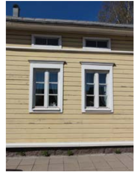
Kuva 16. Haukkaikkunat ullakolla ja kuusiruutuiset ikkunat asuintiloissa.
