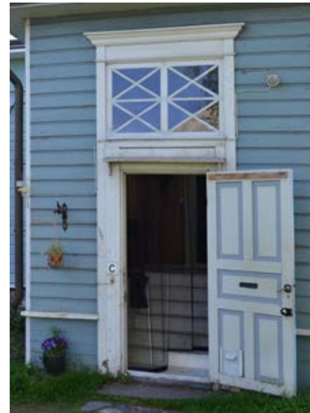
Kuva 20. Ikkunoita sisäänkäynnin yläpuolella.
