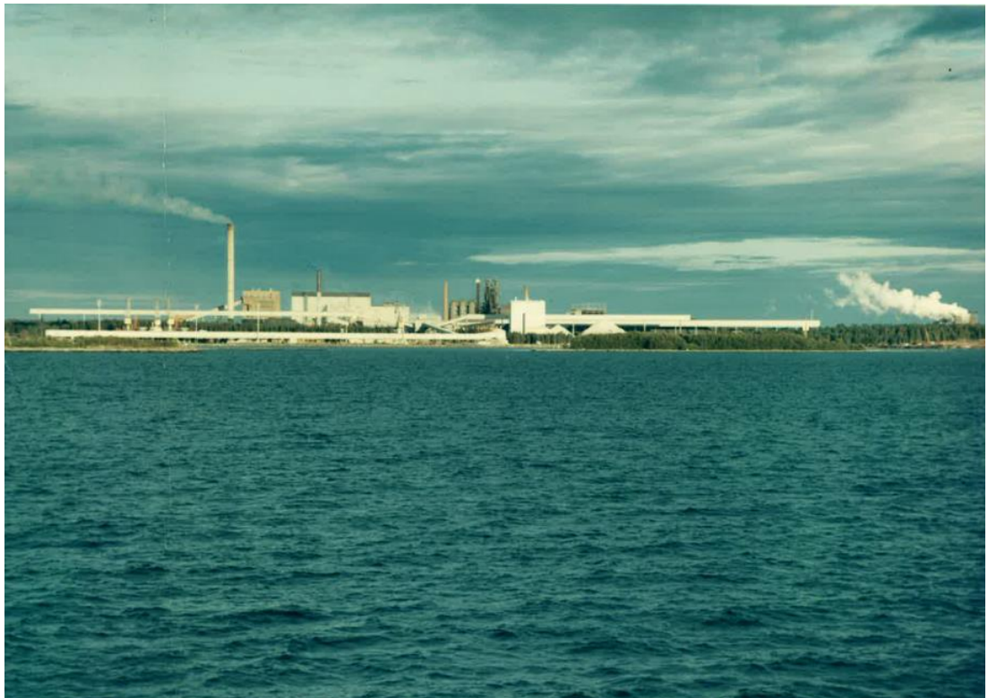
Kuva 11. Tehdasalue mereltä päin nähtynä 1970-luvun lopulla. Mineriittilevy-pinta-aiset kuljettimet muodostavat voimakkaat horisontaaliset viivat maisemassa ja sintraamo, masuunin ja cowperien huiput sekä terässulatto nousevat esille maisemassa. SSAB:n arkisto.
