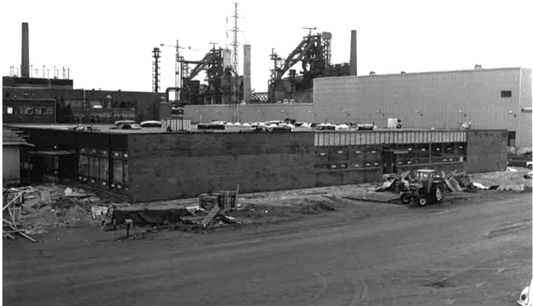
Kuva 111. Ruokala rakenteilla. Taustalla korjaamo, joka on laajennettu nykyiseen kokoonsa ja jonka julkisivu ruokalaa vasten on profiiliteräsvyvä. SSAB:n arkisto.
