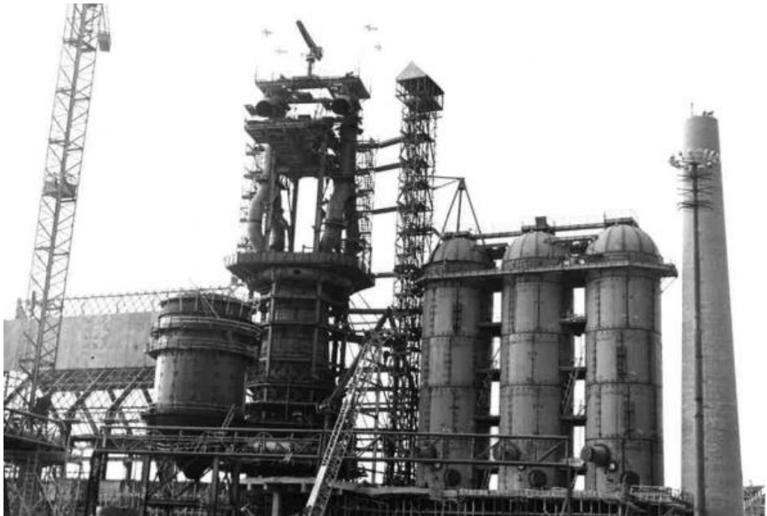
Kuva 32. Ensimmäinen masuuni rakenteilla. Kuva todennäköisesti harjanostajaisista, koska huipussa on Suomen liput. SSAB:n arkisto.
