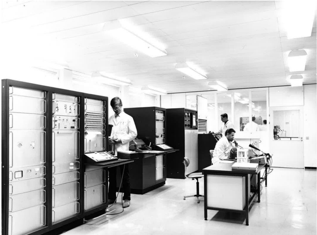
Kuva 104. Tutkimuslaitoksen vastavalmistuneet sisätilat 1968. SSAB:n arkisto.
