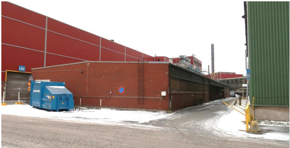
Kuva 109. Valssaamon huoltorakennus vuonna 2023. Rakennus on jäänyt "puristuksiin" valssaamon laajennuksen ja vedenkäsittelylaitoksen väliin.
