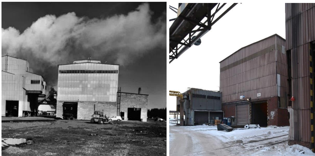
Kuva 80. a. Senkkakorjaamo alkuperäisessä koossaan ja asussaan. SSAB:n arkisto. b. Senkkakorjaamo vuonna 2023.
