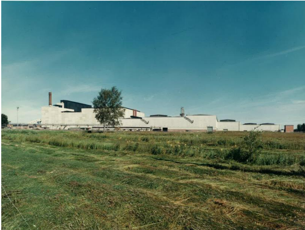
Kuva 97. Valssaamo 1970-luvulla, kun julkisivut olivat asbestisementtilevyä. SSAB:n arkisto.
