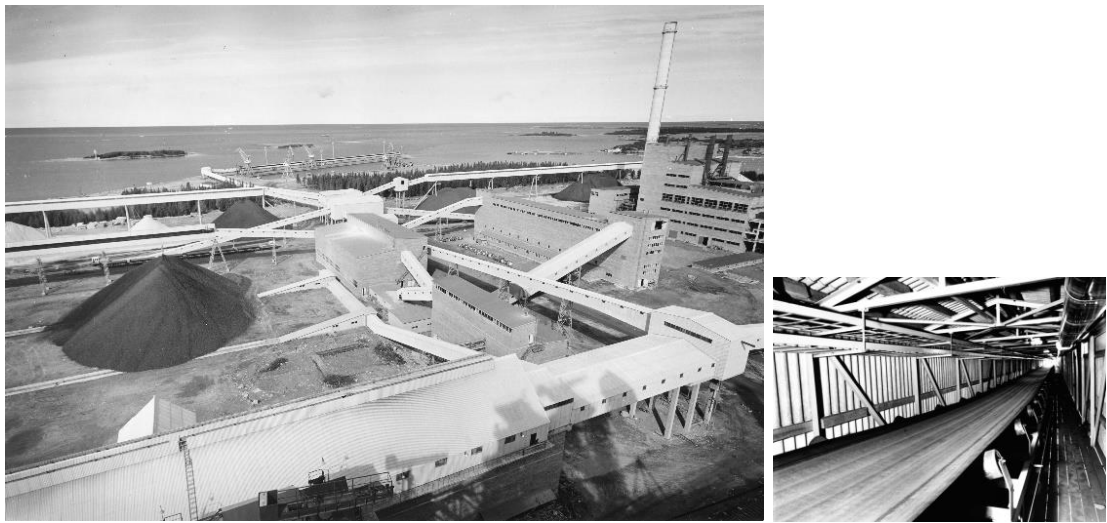
Kuva 14. a. Kuljettimia oli alun perin sataman, sintraamon ja materiaalivarastojen sekä masuunin välillä. Ne oli päällystetty aaltoprofiloidulla asbestisementtilevyllä ja erottuivat maisemassa vaaleina viivoina. Raahen kaavoituksen arkisto. b. Kuljetin sisältä päin katsottuna. SSAB:n arkisto.
