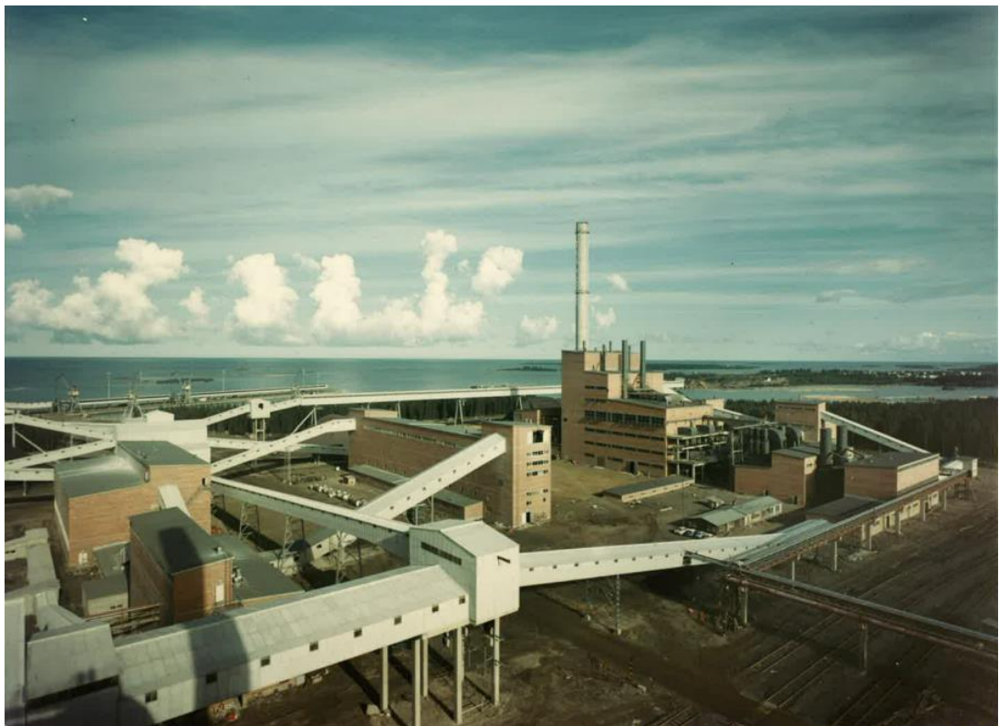
Kuva 41. Vastavalmistunut sintraamo ja siihen liittyvät kuljettimet. Punatiiliset rakennukset ovat vasemmalta oikealla murskaamo, annostelulaitos ja itse sintraamo. SSAB:n arkisto.
