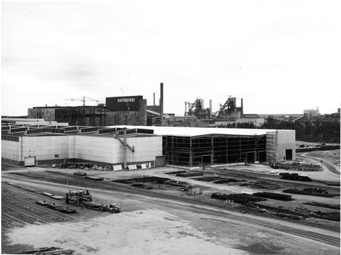
Kuva 95. Valssaamon laajennustyömaa 1974 ja taustalla terässulaton laajennustyömaa. Kuva SSAB:n arkisto.
