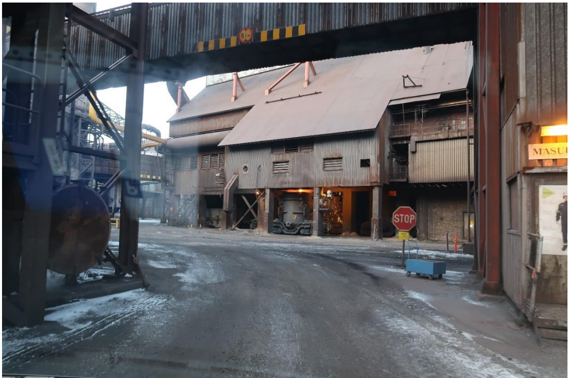
Kuva 37. Raudanlasku masuunista senkaan vuonna 2023. Sääsuojarakenteet ovat profilipeltiä.
