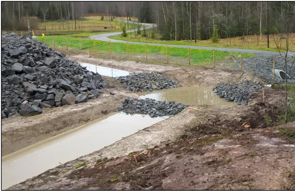
Kuva 9. Esimerkki rakentamisen aikaisesta laskeutusaltaasta ja suotopadosta.
