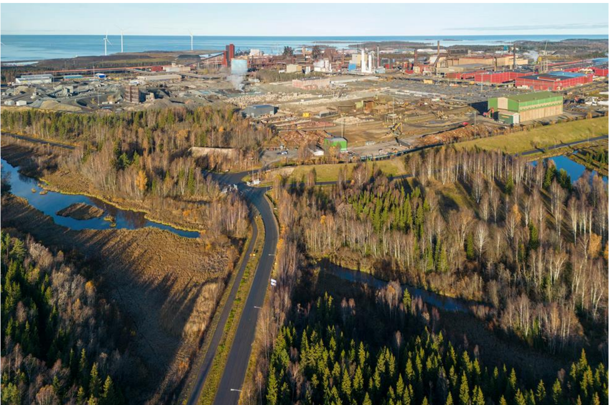
Kuva 4-29. Ilmakuva teollisuusalueelle kaakosta, Koksaaotien suunnasta. Kuvassa keskellä näkyy uuden rakentamisen alue.
