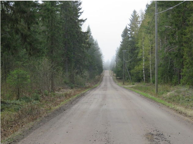
9. Iolinnan tie kuvattuna länteen.
