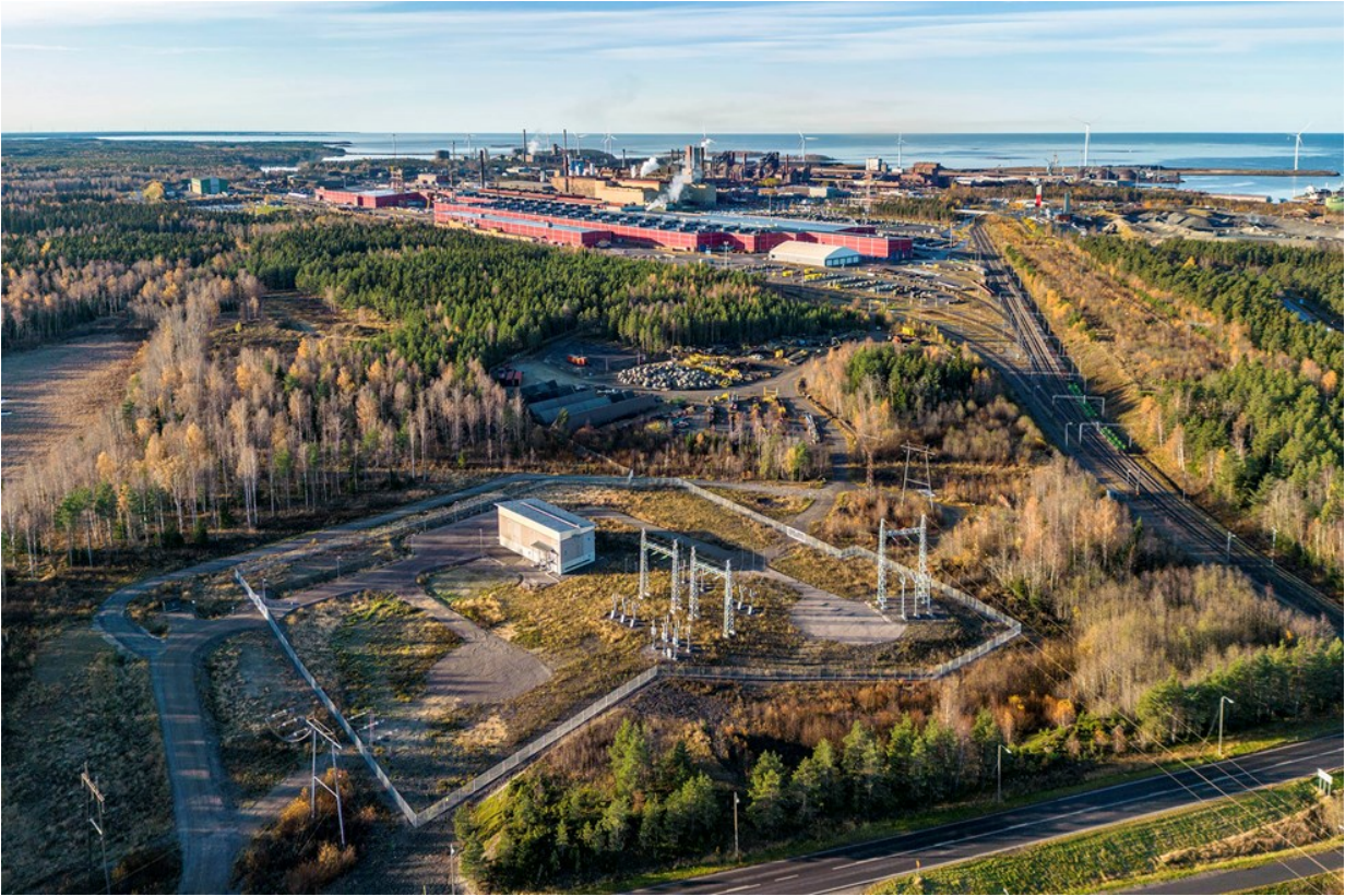
Kuva 4-28. Ilmakuva teollisuusalueelle koillisesta. Oikealla näkyy teollisuusalueelle johtava rata.
