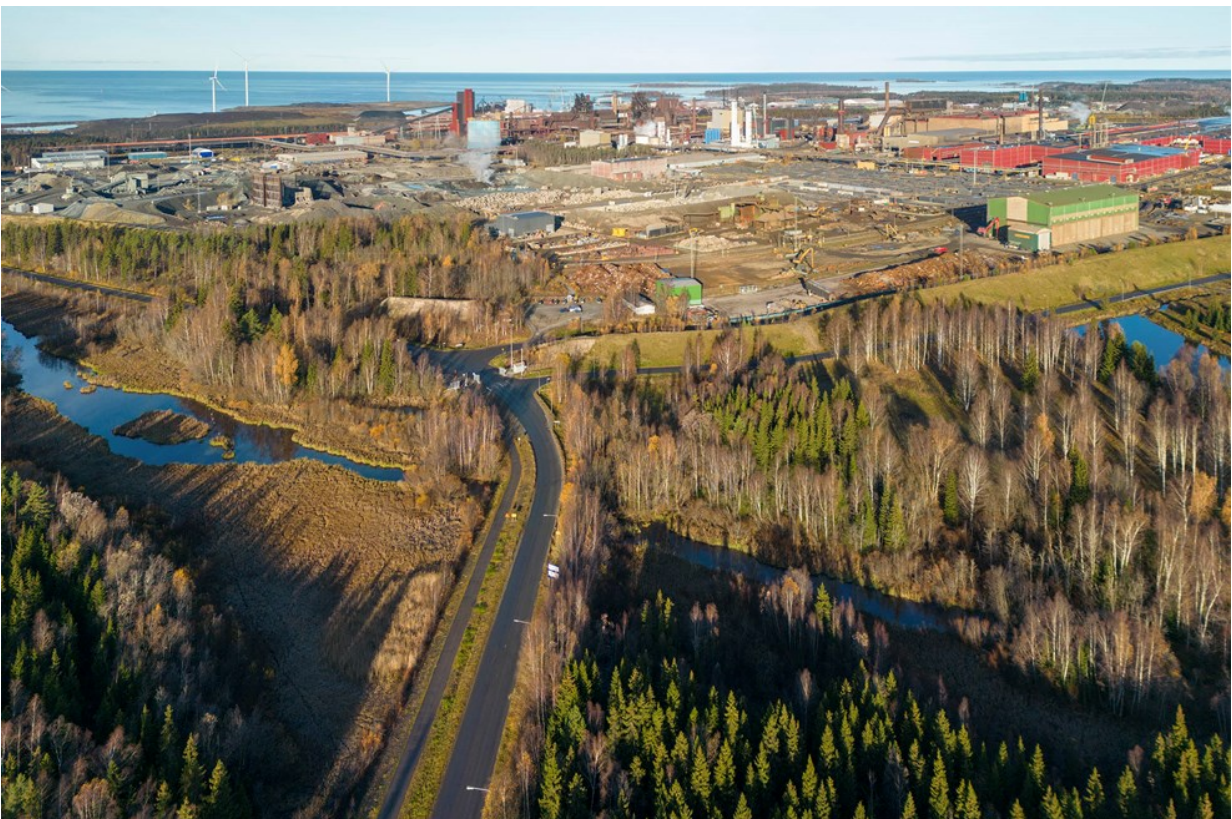
Kuva 4-29. Ilmakuva teollisuusalueelle kaakosta, Koksamotien suunnasta. Kuvassa keskellä näkyy uuden rakentamisen alue.
