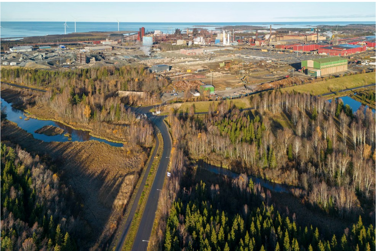
Kuva 4-24. Ilmakuva teollisuusalueelle kaakosta, Koksamotien suunasta. Kuvassa keskellä näkyy uuden rakentamisen alue.
