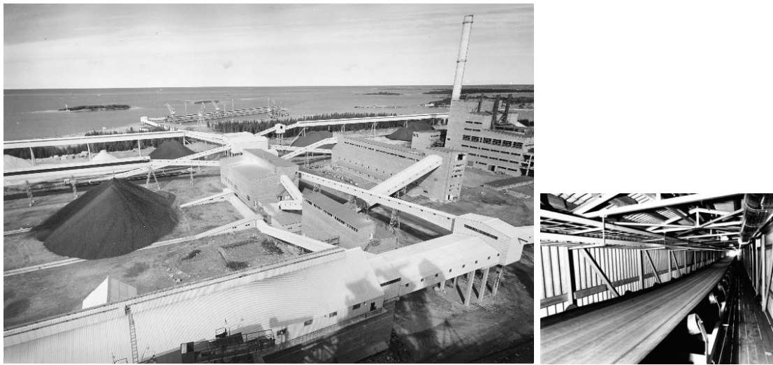
Kuva 14. a. Kuljettimia oli alun perin sataman, sintraamon ja materiaalivarastojen sekä masuunin välillä. Ne oli päällystetty aaltoprofiloidulla asbestisementtilevillä ja erottuivat maisemassa vaaleina viivoina. Raahen kaavoituksen arkisto. b. Kuljetin sisältä päin katsottuna. SSAB:n arkisto.
