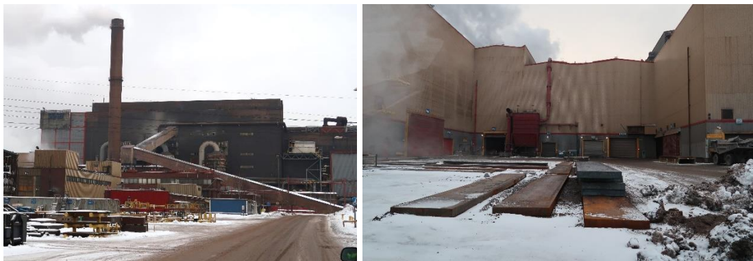
Kuva 89. a. ja b. Terässulattoa eri suunnista vuonna 2023. Julkisivut ovat eri värisiä eri suunnista ja laajennukset ovat muuttaneet massoittelua alkuperäisestä levottomammaksi luonteeltaan.
