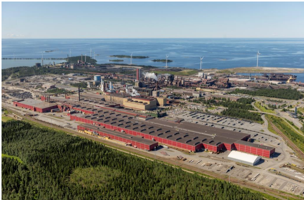
Kuva 98. Valssaamo etualalla ilmakuvasssa vuonna 2016. Julkisivut on pinnoitettu punaisella teräslevyllä. SSAB:n arkisto.
