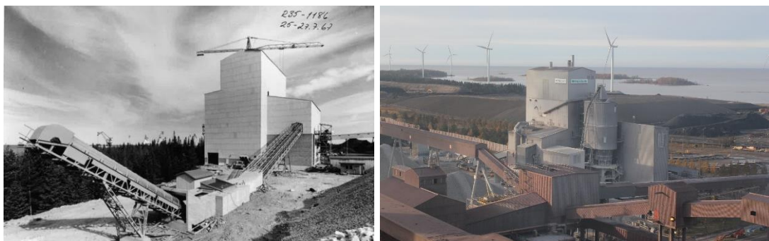
Kuva 110. a. Kalkinpolttamon ensimmäinen vaihe rakenteilla heinäkuussa 1967. b. Kalkinpolttamo vuonna 2016, ote ilmakuvasta. Taustalla näkyvät alueen rantaan sijoitetut tuulimyllyt. SSAB:n arkisto.
