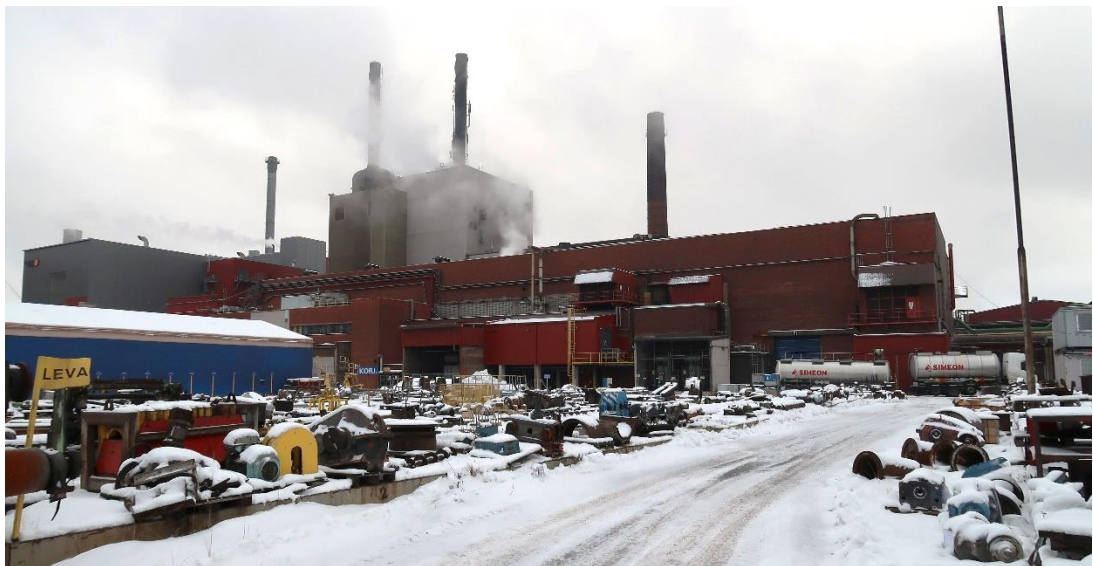
Kuva 54. Voimalaitos vuonna 2023 pohjoisen suunnasta katsottuna. Ensimmäisen vaiheen tiliseinä lasitiiliaukkoineen näkyy etualalla olevien matalampien osien takana.
