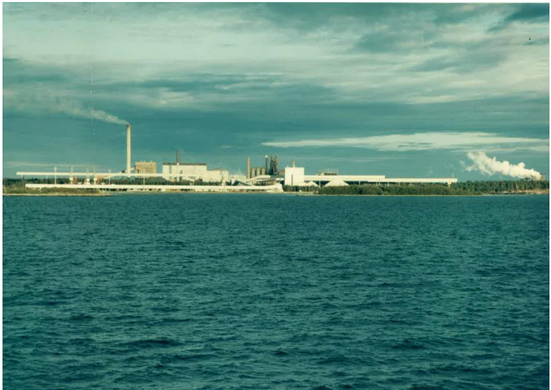
Kuva 11. Tehdasalue mereltä päin nähtynä 1970-luvun lopulla. Mineriittilevy-pinta-aiset kuljettimet muodostavat voimakkaat horisontaaliset viivat maisemassa ja sintraamo, masuunin ja cowperien huiput sekä terässlatto nousevat esille maisemassa. SSAB:n arkisto.
