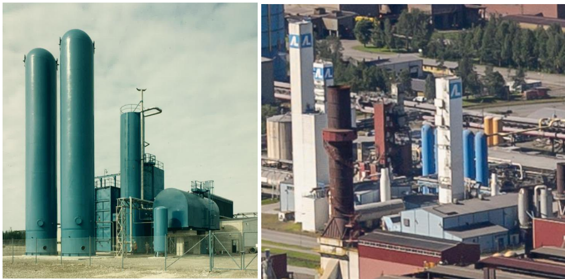
Kuva 106. a. Ilmakaasulaitoksen ensimmäinen vaihe. b. Ilmakaasulaitos vuonna 2016. Ote ilmakuvasta. SSAB:n arkisto.
