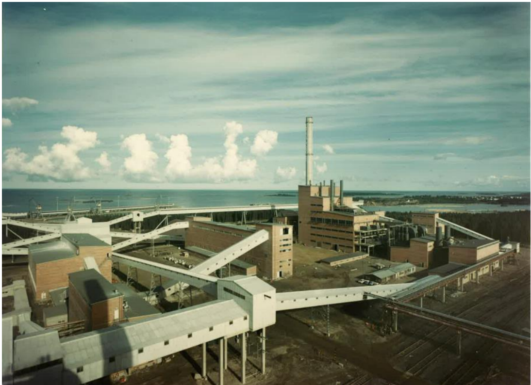
Kuva 41. Vastavalmistunut sintraamo ja siihen liittyvät kuljettimet. Punatiiliset rakennukset ovat vasemmalta oikealla murskaamo, annostelulaitos ja itse sintraamo. SSAB:n arkisto.
