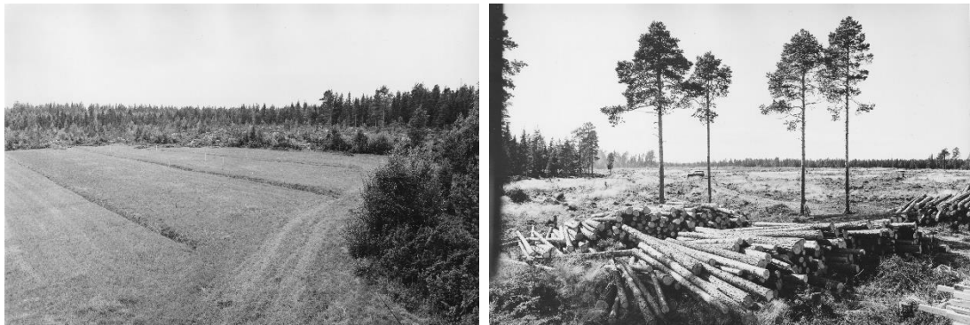
Kuva 12. a ja b. Tehtaан raivausalueita 4.8.1961, vasemmalla harkkovalimon kohdalla. Kuvat Raahen museo.
