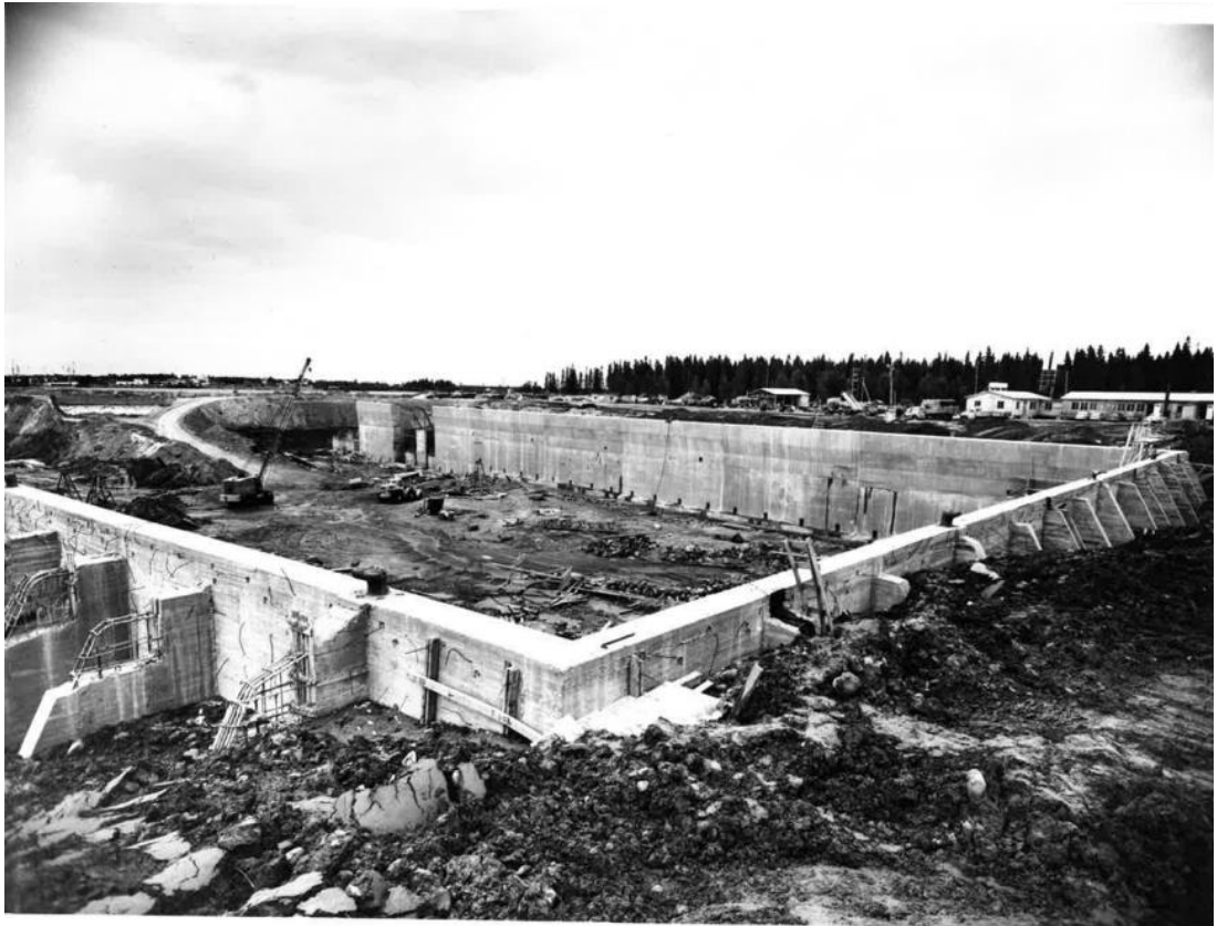
Kuva 15. Satama-allasta rakennetaan. Betonityössä käytettiin siirrettäviä suurmuotteja. SSAB:n arkisto.
