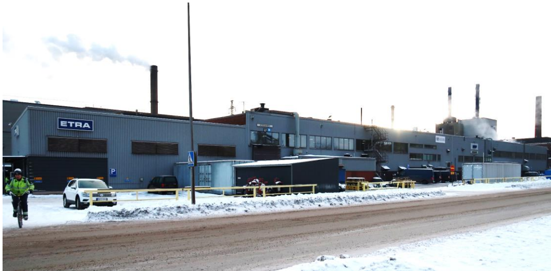
Kuva 63. Korjaamo vuonna 2023. Julkisivut on pellitetty, vain alareunassa on paikoin tiiltä näkyvissä. Lasitiiliaukot on vaihdettu ikkunoiksi ja savupiippu on purettu.
