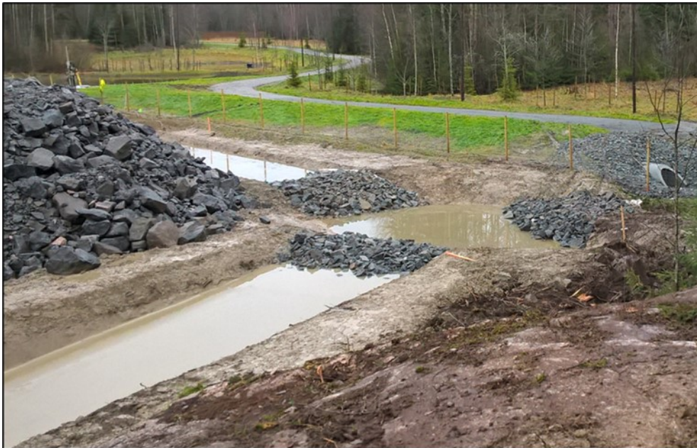
Kuva 9. Esimerkki rakentamisen aikaisesta laskeutusaltaasta ja suotopadosta.
