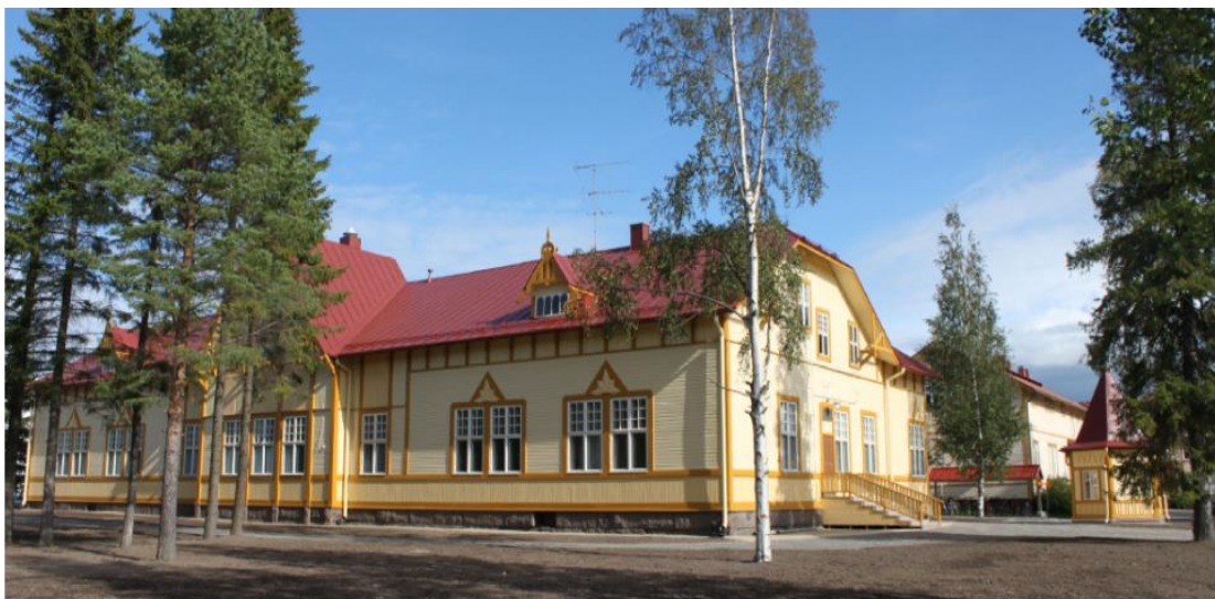
Kuva 8: Kaava-alueella olevat maakunnallisesti arvokkaat Gellmanin sairaalan rakennukset. Etualalla rakennus G ja oikealla takana rakennus H. © Ilpo Väisänen.
