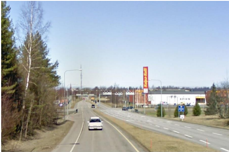
Näkymä Kokkolantien alkupäästä kohti Raahen keskustaa (Google Street View)
