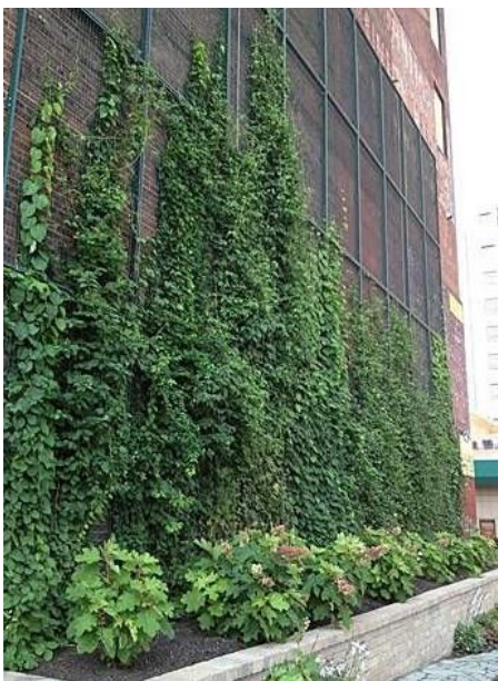
Kuva 30 Viherseinä toteutettu julkisivuun kiinnitetyllä teräsverkolla. Kuva: www.weldedwire-meshpanel.com
