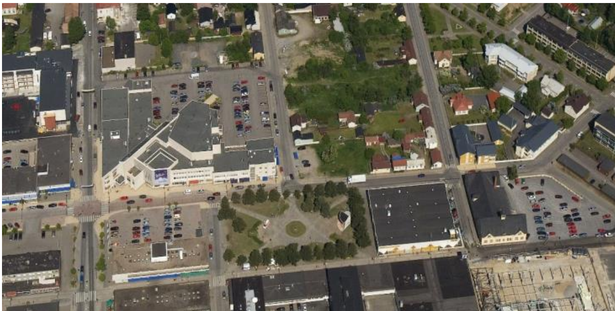
Kuva 3 Viistoilmakuva Härkätorin ympäristöstä vuodelta 2007. Prisma on rakenteilla kuvan oikeassa alareunassa. Kuvälähde: Raahen kaupunki.
