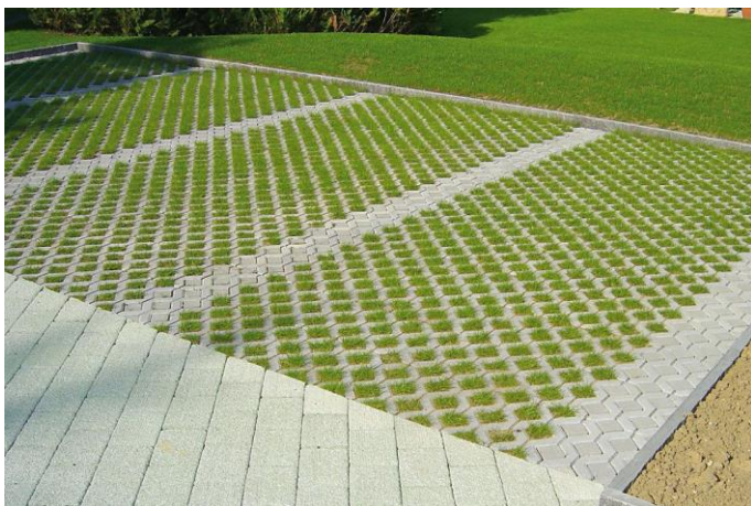
Kuva 19 Pysäköintiruudut on kivetty läpäisevällä nurmikivellä. Kuva: www.archiexpo.com
